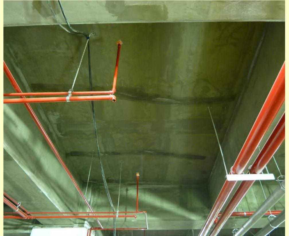
樓版裂縫，導致滲水！—初凝後整體粉光？混凝土添加物？
