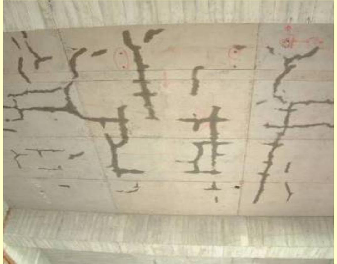
樓版裂縫，導致滲水！—初凝後整體粉光？混凝土添加物？
