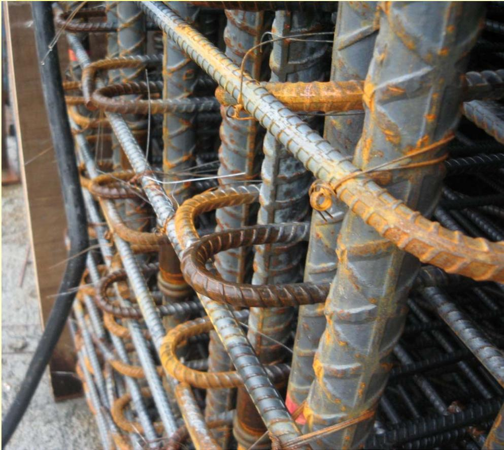
柱箍筋繫筋與主筋之間隙過大
