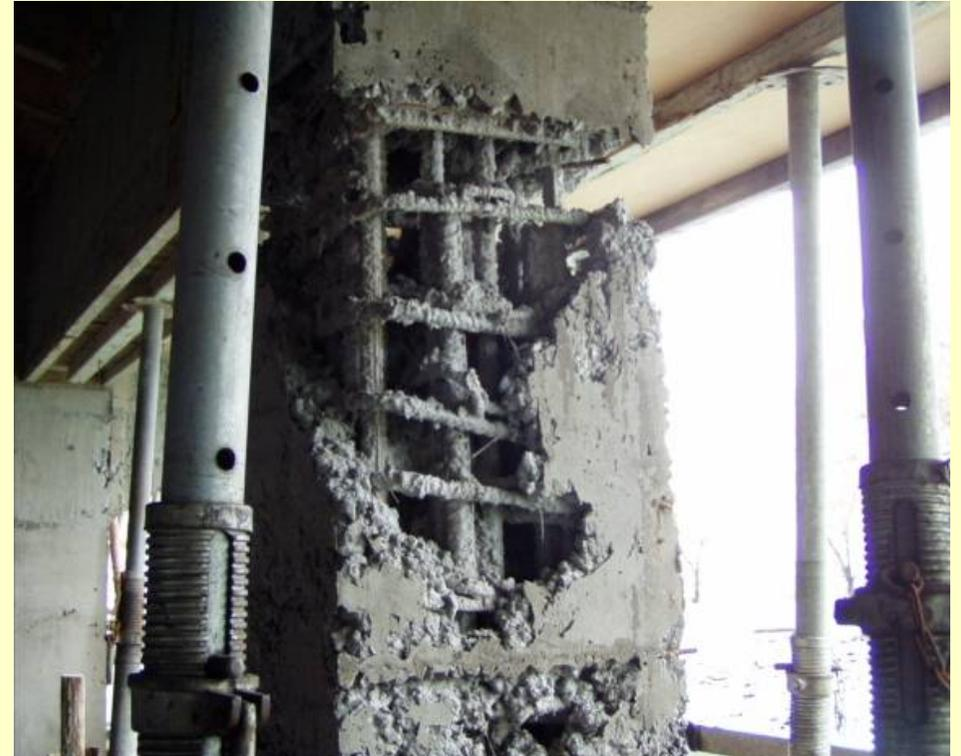
混凝土完成面有嚴重粒料析離及蜂窩情形，另混凝土澆置及搗實不良，造成構件完成面不連續。
