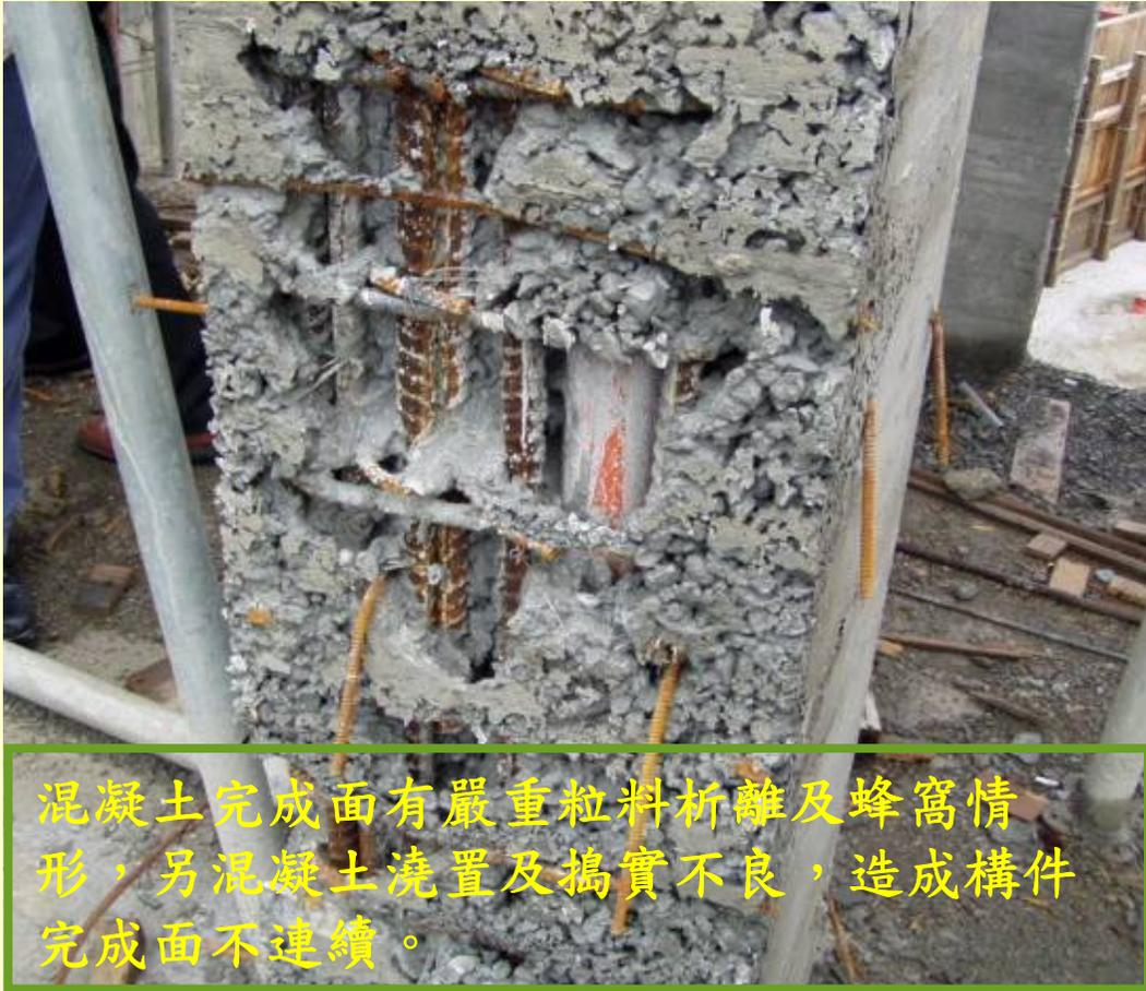
混凝土完成面有嚴重粒料析離及蜂窩情形，另混凝土澆置及搗實不良，造成構件完成面不連續。
