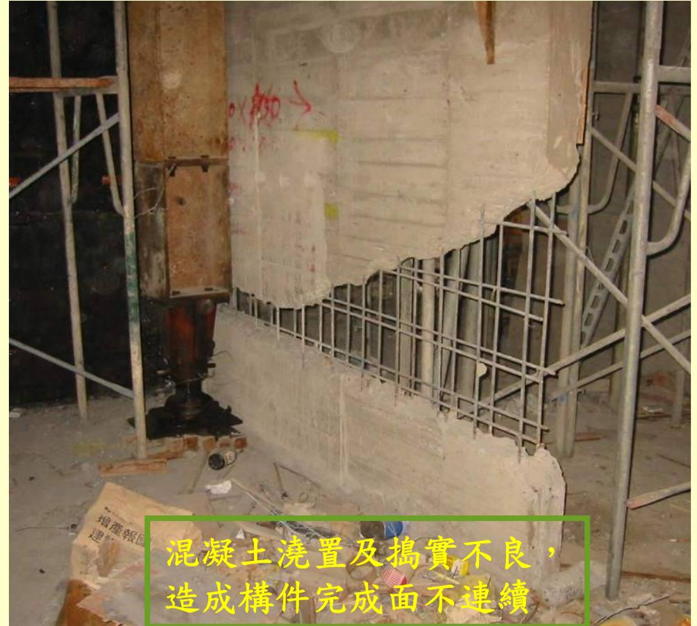
混凝土澆置及搗實不良，造成構件完成面不連續
