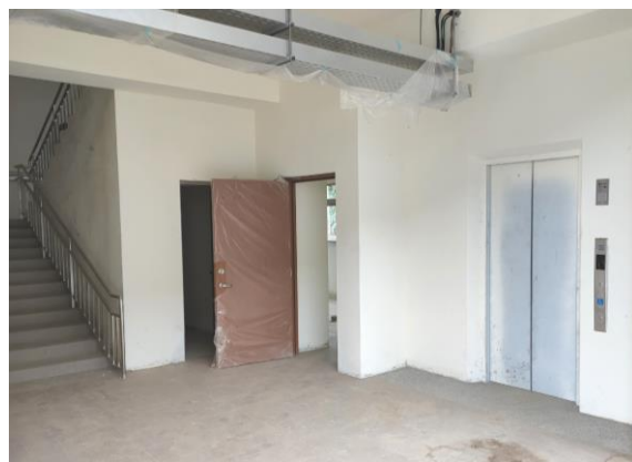
幼兒園 外觀(南 側)及電 梯
