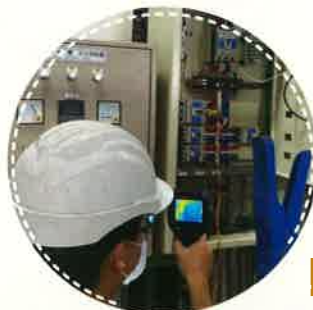
電力盤熱點量測
