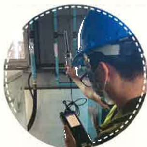
設備機房溫度檢測
