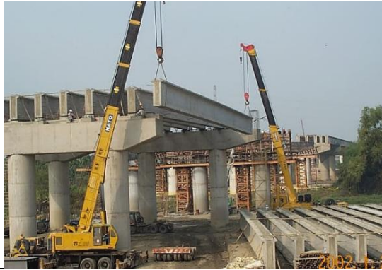
照片 9：預力梁之預鑄與吊放作業
