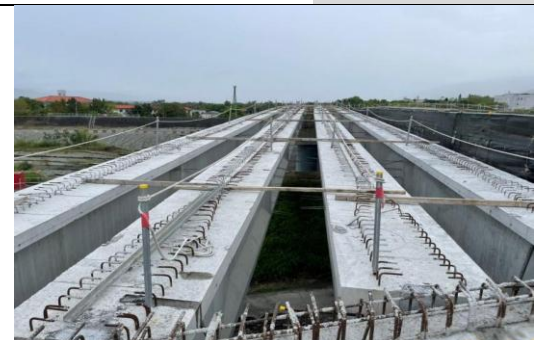
照片 8：吊放後-木料角材橫向連結
