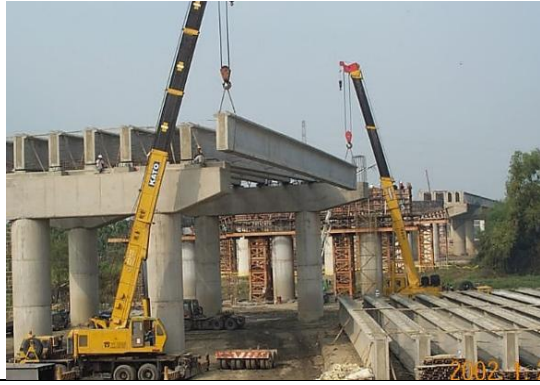
照片 9：預力梁之預鑄與吊放作業
