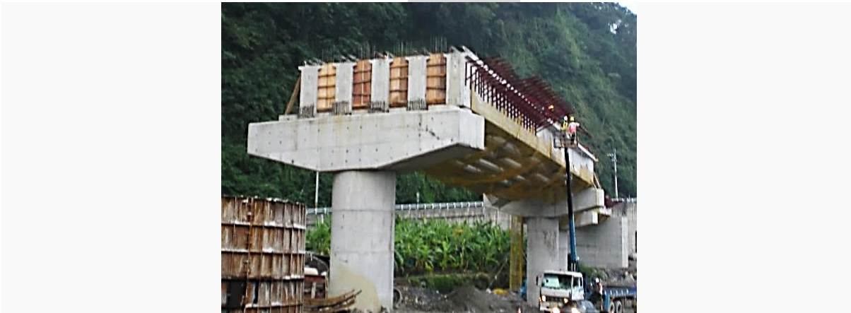
圖 11 端隔梁現場施工圖
