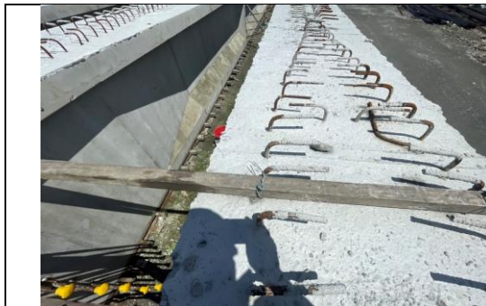
照片 7：吊放前-木料角材橫向連結（以鐵絲綁繫）
