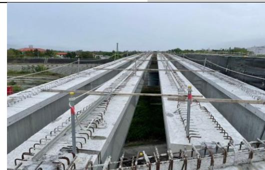
照片 8：吊放後-木料角材橫向連結
