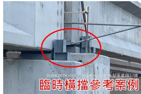
圖 6 帽梁外側設置臨時橫擋
