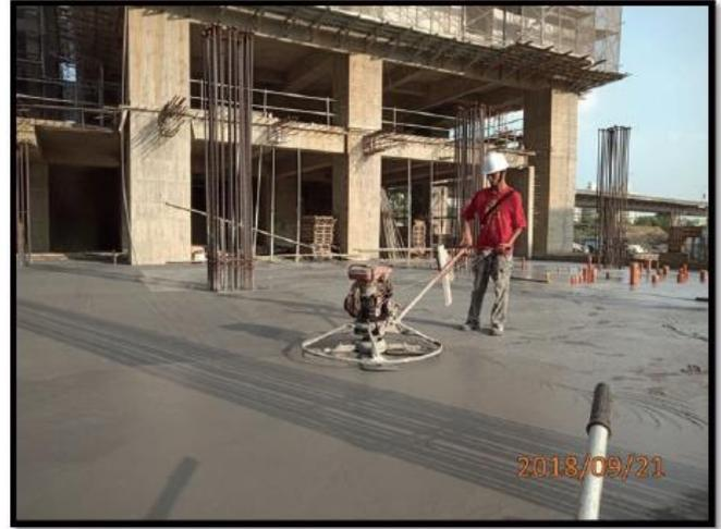
混凝土應進行整體粉光，並加以養護，防止裂縫產生。
