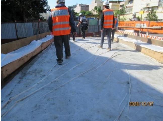
1. 混凝土養護應在表面浮水消失後即進行養護。
