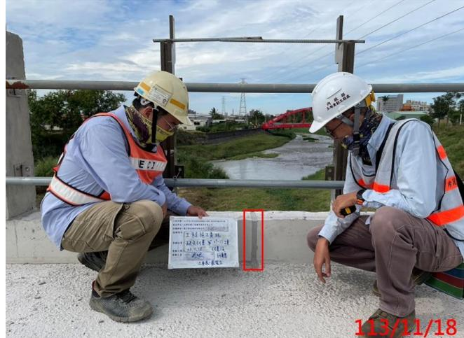
伸縮縫延伸一致並完全斷開，後續應確實依施工規範及圖說施作，並加強品質管控。
