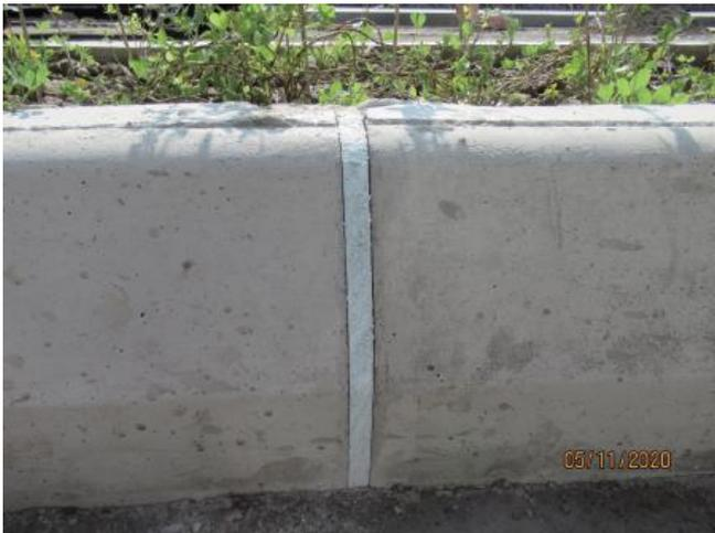
依設計圖說單元與單元間之伸縮縫，於模板組立時，伸縮縫放置保麗龍填料(或圖說規定材料)，待澆置完成後，去除伸縮縫內填充料後，以填縫劑填補接縫處。
